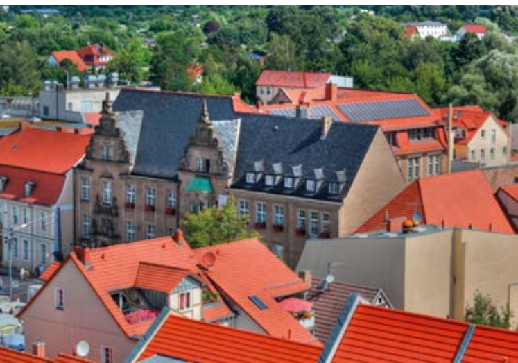
Abb. 12: Photovoltaik auf dem Rathausdach (Quelle: Robert Müller)
