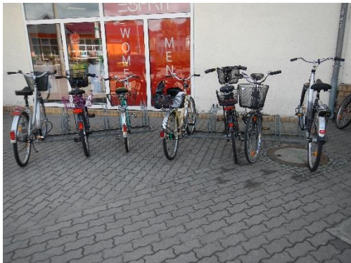
Zum Be- und Entladen ungeeignete Felgenklemmer vor dem Einkaufszentrum in Finow
