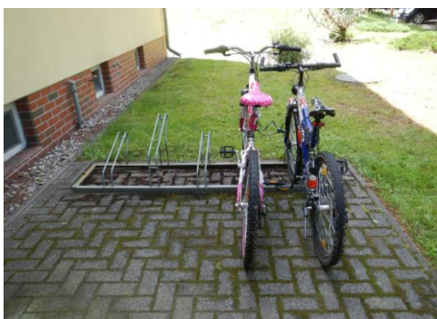
Anlage mit ungeeigneten Felgenklemmern ohne Witterungsschutz
