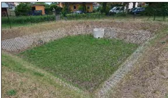
Abbildung 22: Regenrückhaltebecken an der Schönholzer Straße. © M. Olonscheck.
