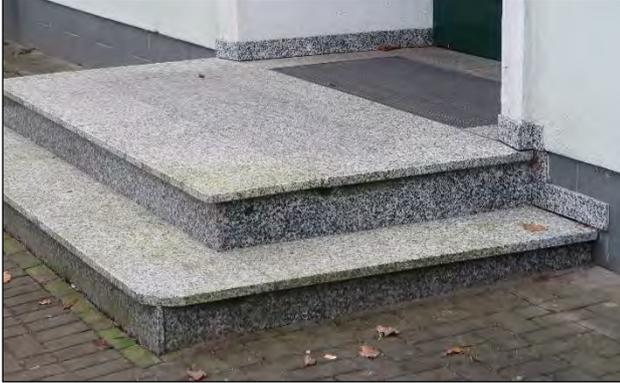
Abbildung 70: Erhöhte Eingänge verhindern ein Eindringen von Regenwasser. © M. Olonscheck.
